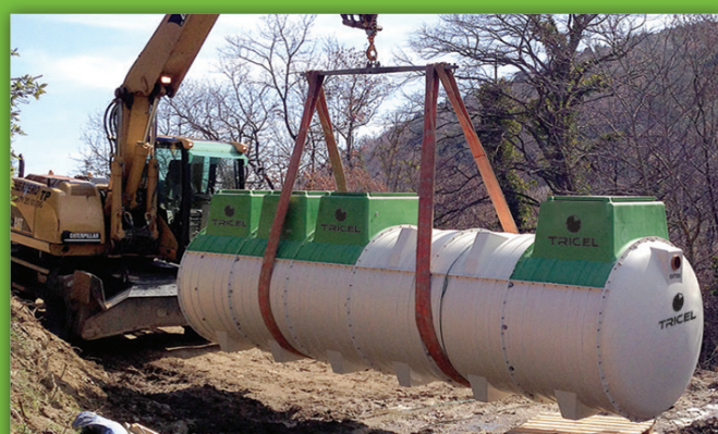
Installation d'une Tricel Novo FR20
