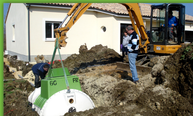
Installation d'une Tricel Novo FR6
